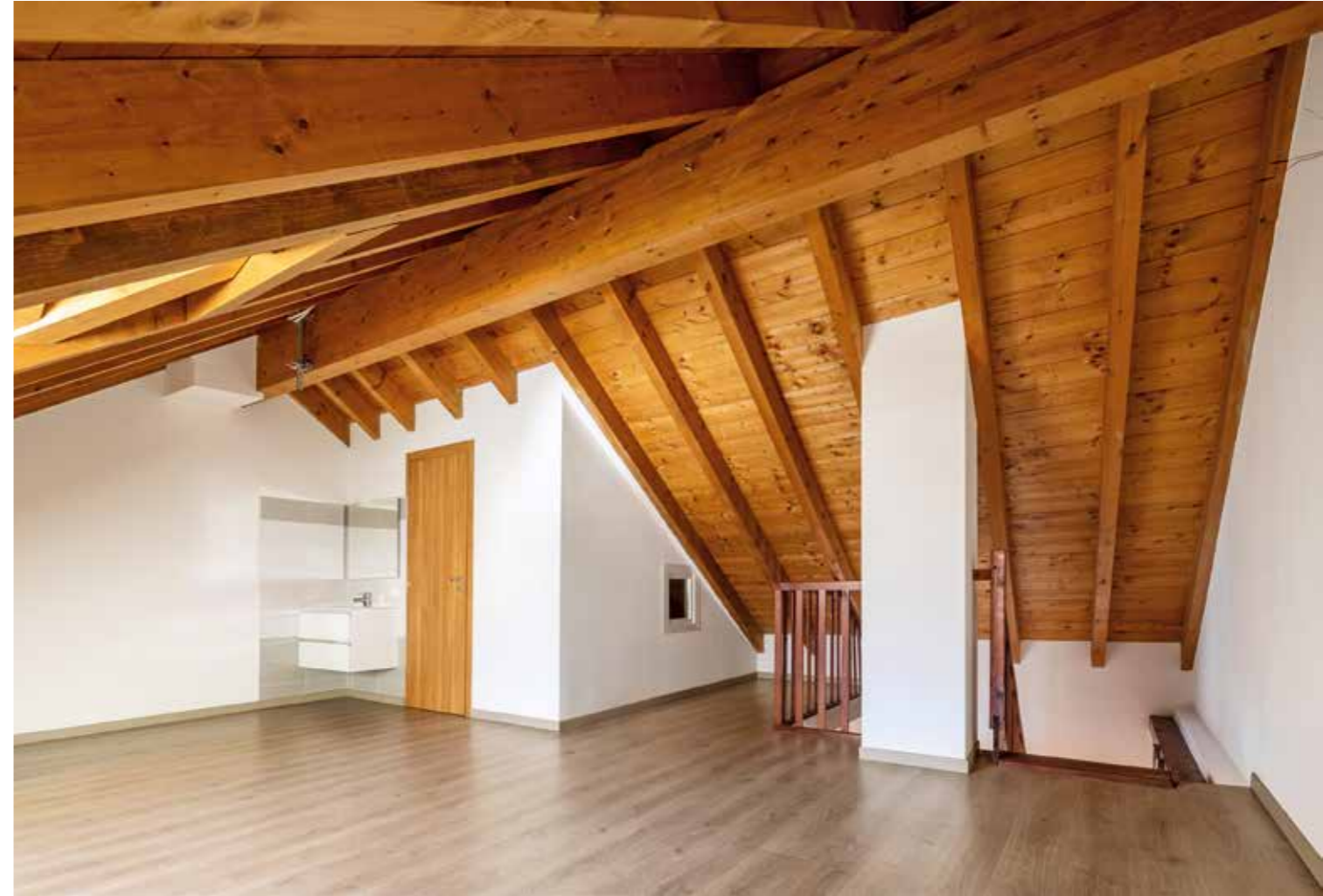
Aus einem gedämmten Dachstock kann neuer Wohnraum entstehen.
